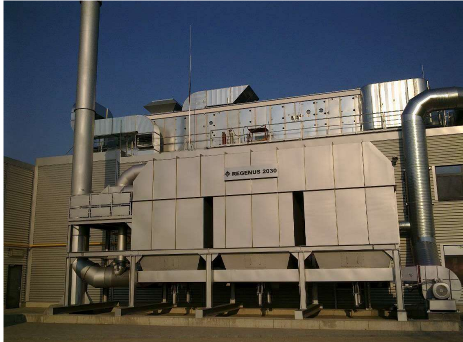
REGENUS-RTO à trois chambres avec échangeur de chaleur pour l'eau chaude.
